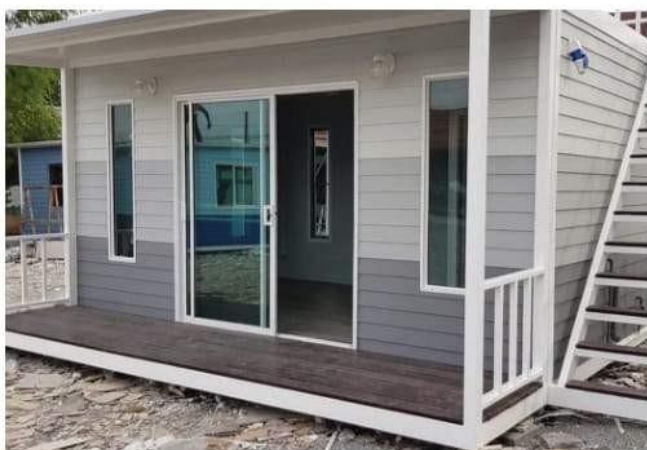
บ้านประกอบเสร็จ
